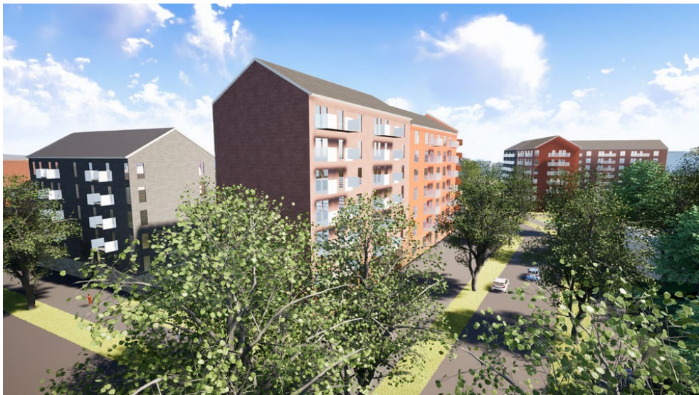
Illustration som visar ett exempel på flerbostadshus längs med Söderslättsvägen.
