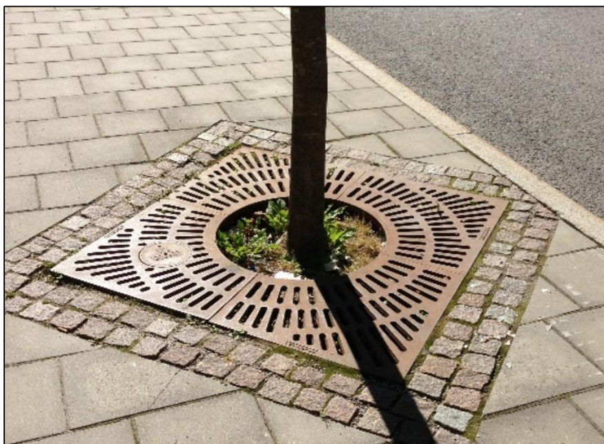
Figur 27. Figuren visar ett förslag på hur träd anlagda med skelettjord kan utformas i gatumiljö (WSP, 2013).
