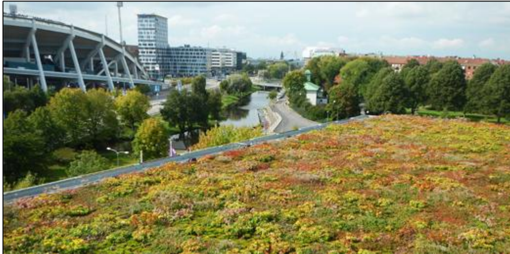
Figur 30. Exempelbild på gröna tak. Bilden är tagen från www.vegtech.se och visar ett sedumtak.
