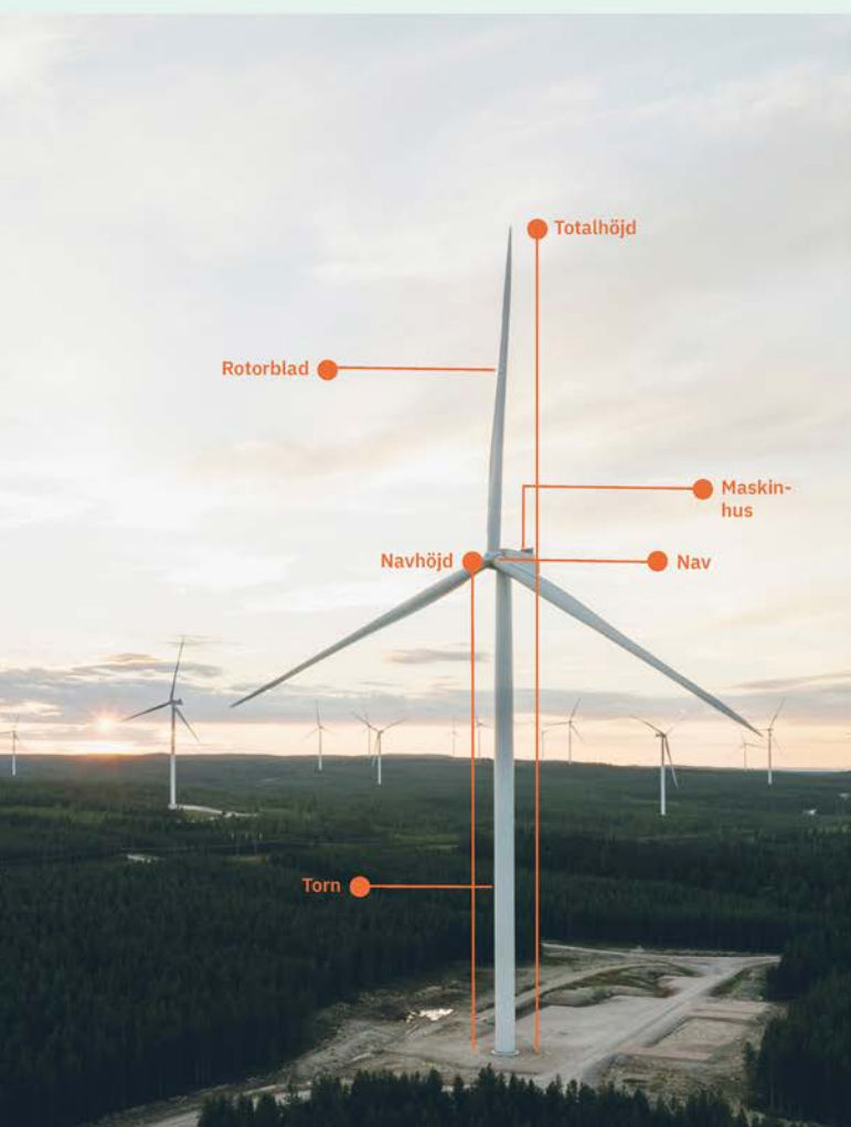
FIGUR 4 Principskiss av vindkraftverkets delar.
