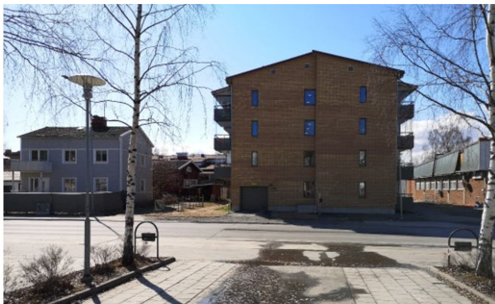
Figur 4. Fotot är taget från Guldkrinet 1 – öster om Rothoffsvägen. Till vänster i bild ett tvåbostadshus uppfört 1939. Mitterst syns ett nybyggt flerbostadshus i fyra våningsplan och till höger skimtar del av industribyggnad inom planområdet som revs 2021.
