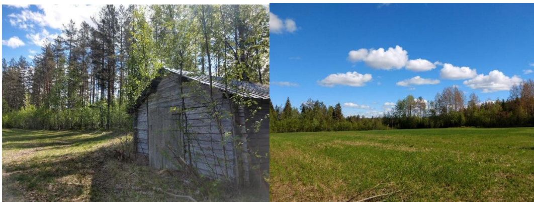
Figur 3 och 4. Bild över befintlig lada i sydvästra delen av planområdet samt vy över norra delen. Källa: Sweco
