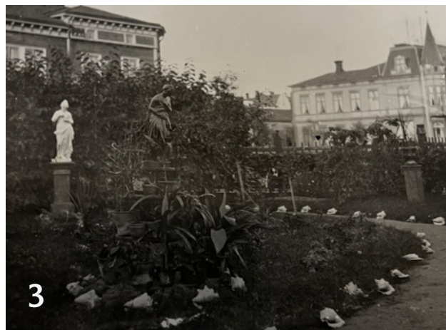
Figur 22. Trädgården tillhörande det Scharinska huset i kvarteret Njord, fotograferat från sydväst Trädgården låg i hörnet Kungsgatan-Renmarksesplanaden och här uppförde guldsmed K E Berg sitt hus 1905. I bakgrunden syns "Färgare Sandbergs hus" i kvarteret Audumbla till vänster och centralhotellet i kvarteret Balder till höger. Foto: Västerbottens museum
