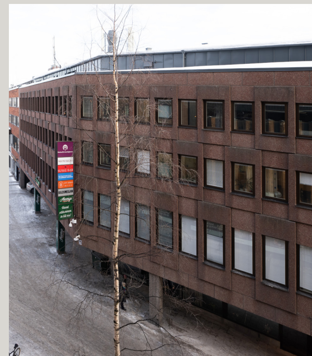
Figur 178. Fasad mot nordöst, passagen mellan Renmarkstorget och Storgatan.
