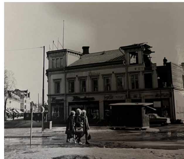
Figur 84. Centrumhuset rivs, 1961. VBM A 25104 Foto: C Norberg/Västerbottens museum
