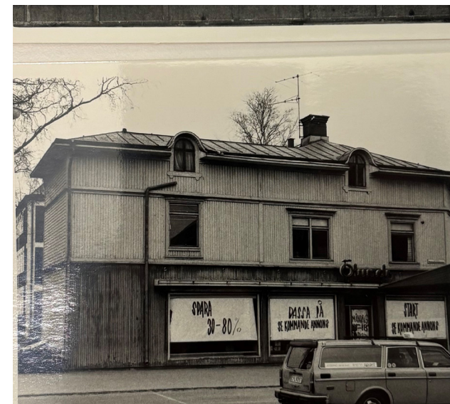
Figur 35. Audumbla 4, 1980. Vy från Renmarksesplanaden. Dokumentation inför rivning, Umeå Stadsarkiv
