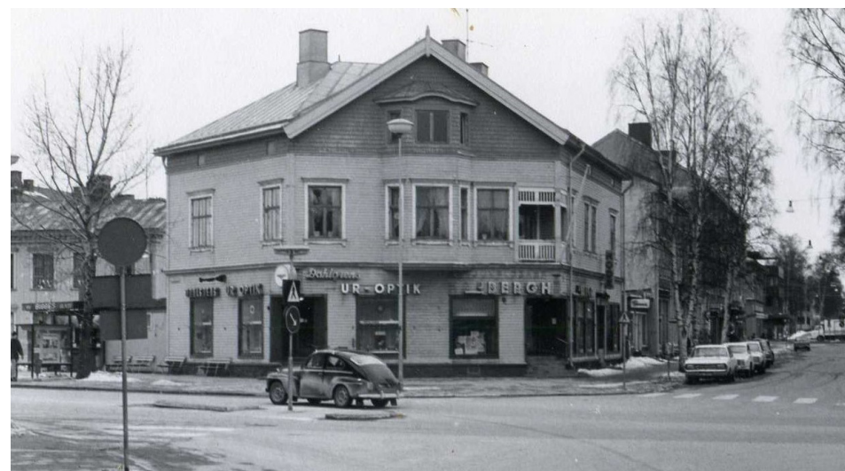
Figur 27. Guldsmed K E Bergs hus byggt 1905 i hörnet Renmarksesplanaden-Kungsgatan. Fotograferat från nordöst. Till vänster skymtar det Scharinska huset. Tidigt 1970-tal. VBM BR 4851 Foto: Otto Eliasson/Västerbottens museum
