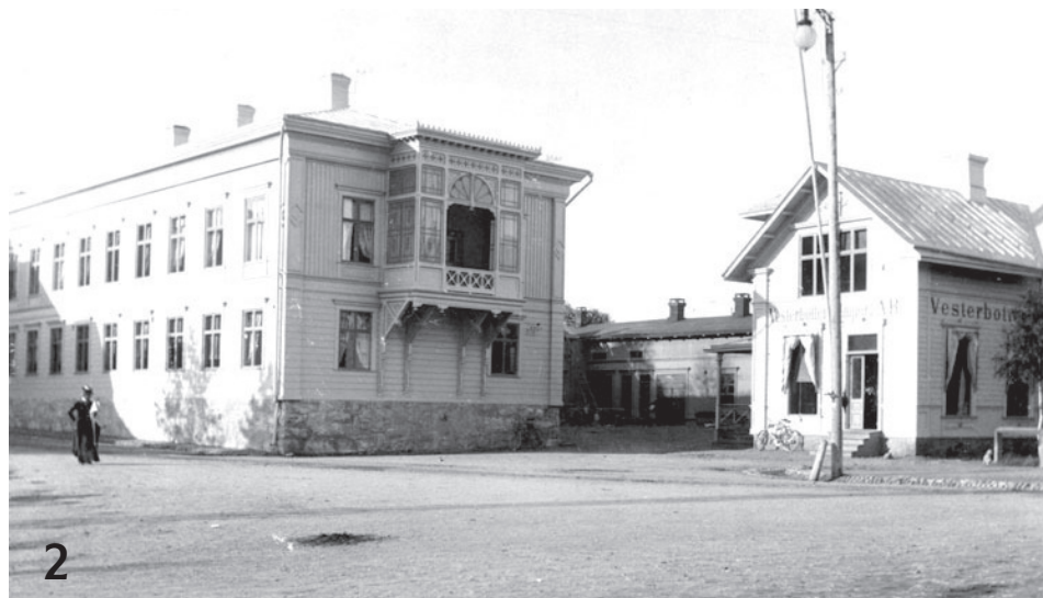
Figur 21. Vy från sydöst. Den sydöstra delen av nuvarande kvarteret Njord, omkring år 1900. Till höger, en butiksbyggnad. Till vänster, det Lindbergska (senare Cygneiska huset). VBM BE 19000000 4 Foto: Bertil Ekholtz samling/Västerbottens museum
