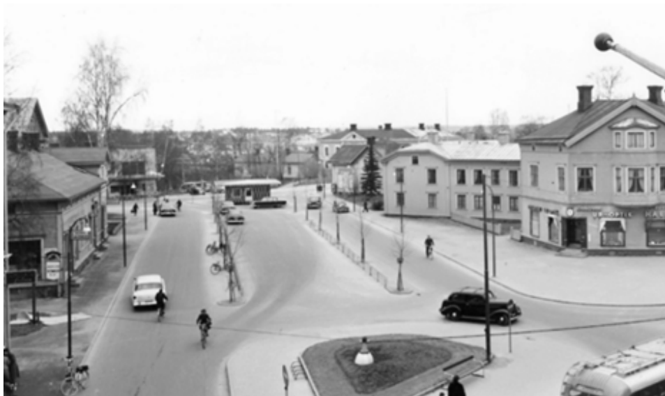
Figur 18: Vy över Renmarksesplanaden mot söder, 1954. Till höger i bild kvarteret Njord. Foto: Bertil Ekholz/Västerbottens museum
