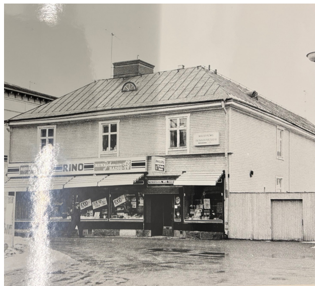
Figur 34. Audumbla 3, 1979. Vy från Renmarksesplanaden. Dokumentation inför rivning, Umeå Stadsarkiv
