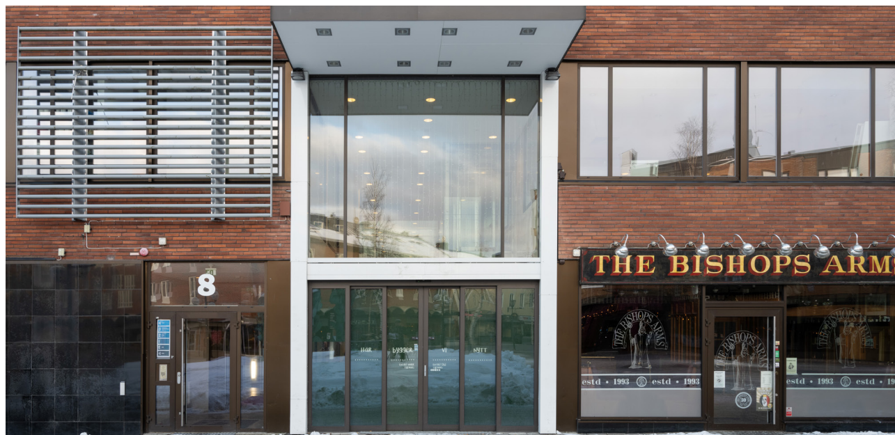
Figur 113. Gallerians uppglasade entré mot Renmarkstorget med nytt skärmtak, 2025. Till vänster skylthållare i grått. Foto: Petter Engman, Västerbottens museum
