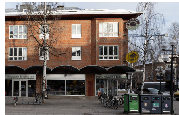
Figur 106. Tunnor för återvinning, vägvisare samt fasadskylt på hörn vid fastigheten Audumbla, fotat från söder. Foto: Petter Engman/Västerbottens museum
