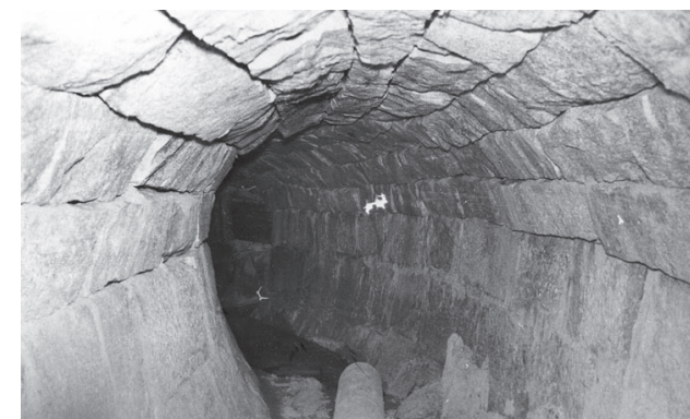
Figur 15. Kulverten för Renmarksbäcken som tillkom på 1890-talet. Fotografiet är från en öppning i samband med nybyggnad av kvarteret Frigg nr 1. Ligger här ca 280 cm under marknivån. På botten ett modernt cementrör. VBM K 9500 Foto: Göte Böhlin/Västerbottens museum
