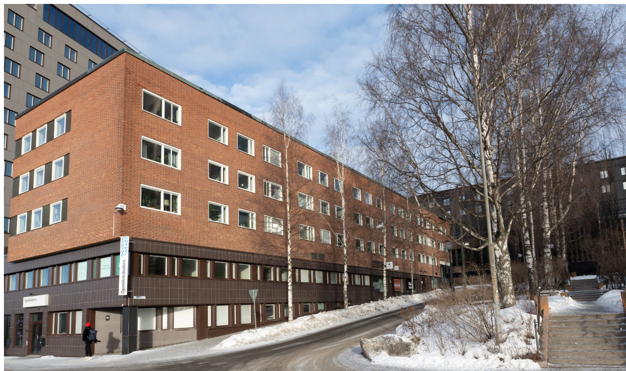
Figur 188. Östra fasaden vid Magne 6 går längs Renmarksesplanaden.
