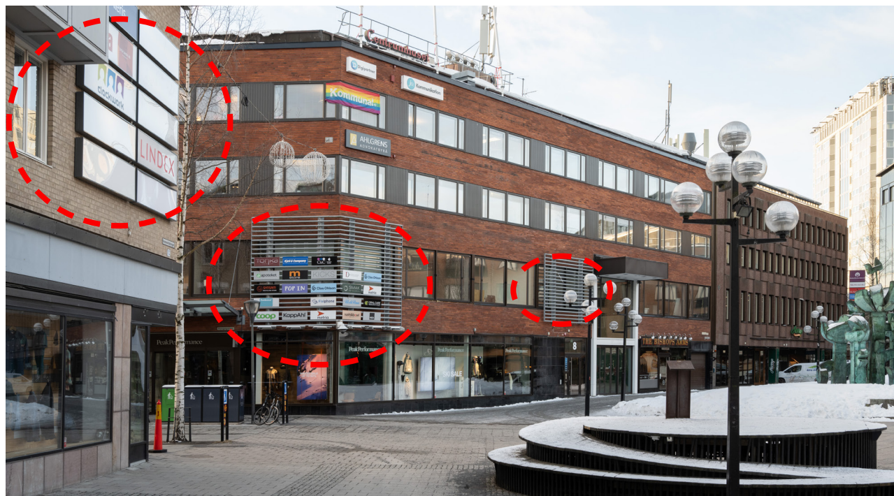
Figur 104: Nya inslag är rödmarkerade i bild. I bakgrunden syns fasadskyltning i kvarteret Odin och Balder. Fasadskyltning på fasader och skyltupphängningsannordning som täcker en del av fasaden. I höger i bild syns talartribunen "Spiralen" invid gågatan Kungsgatans passage över Renmarkstorget. Vy från norr. Foto: Petter Engman/Västerbottens museum
