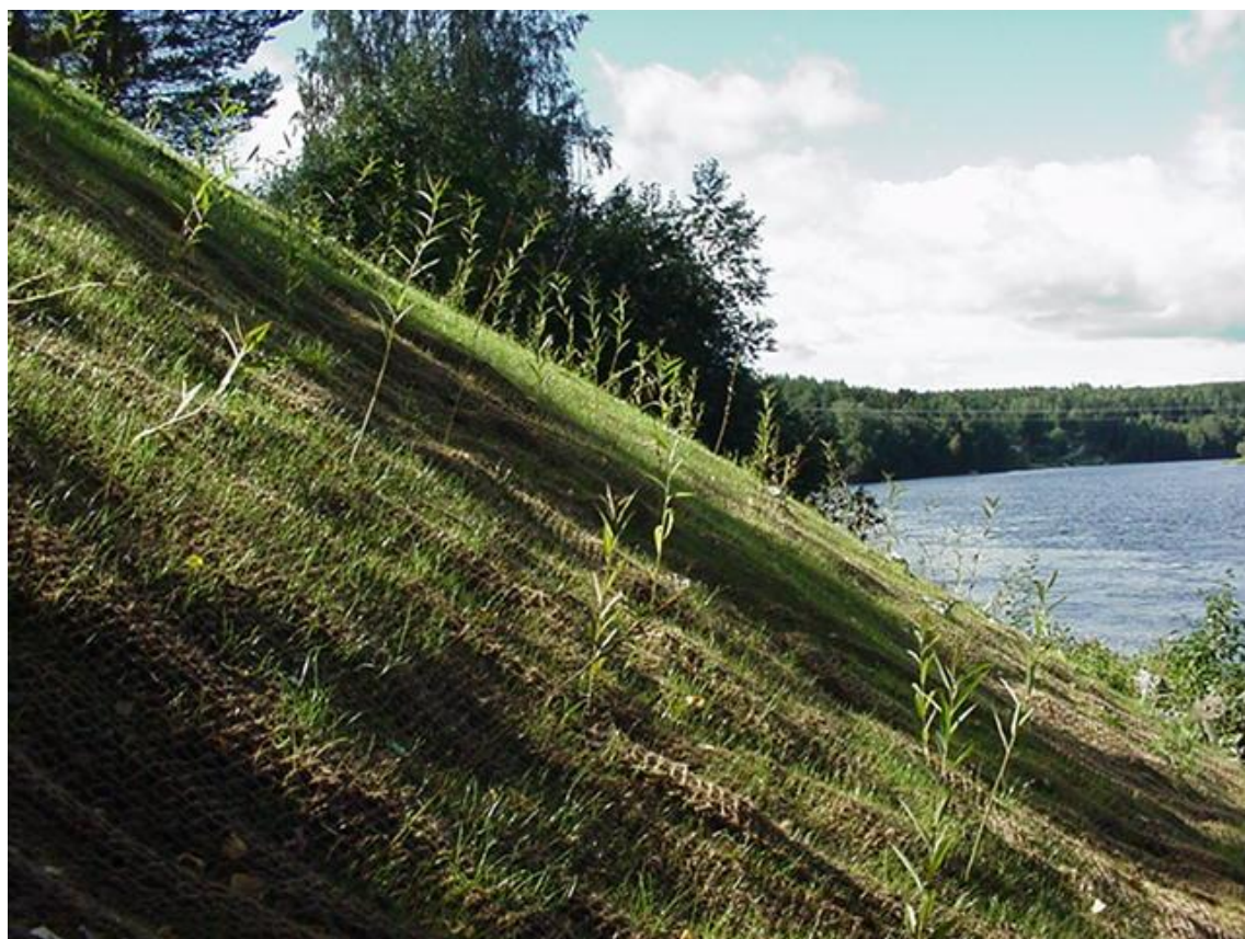
Figur 24. Erosionsskydd i form av kokosmatta.
