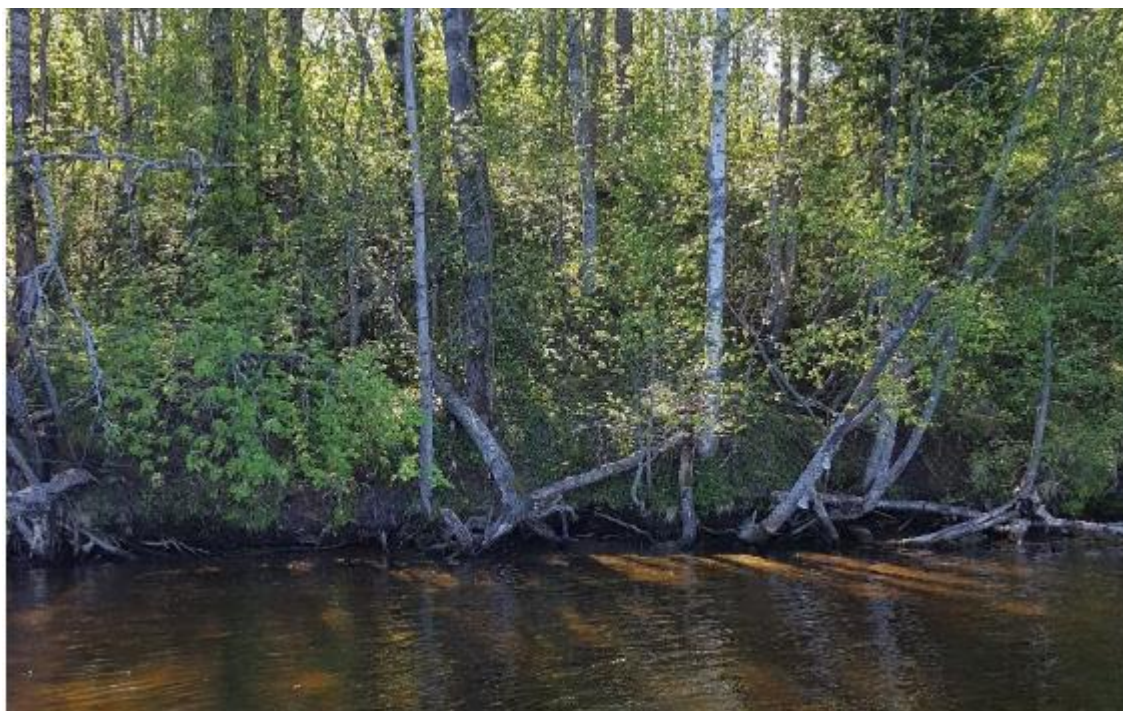
Figur 8. Strandkant i nordöstra delen där viss erosion observerats i form av urspolning under växtligheten.
