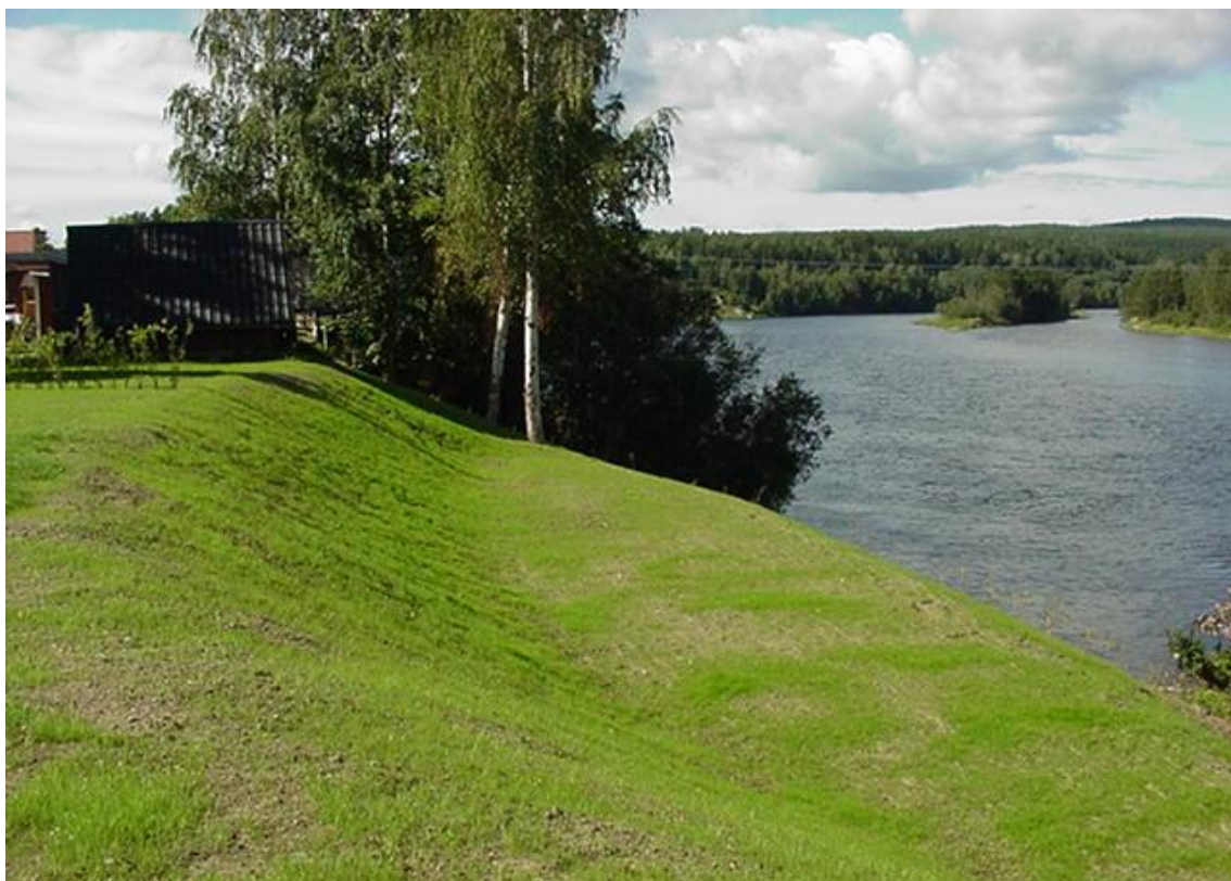
Figur 21. Avlastning i form av nedschaktning av släntrön.
