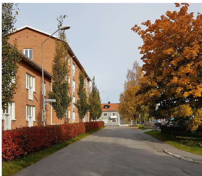
Båtgränd norra del med utblick norrut, mot Storgatan.
