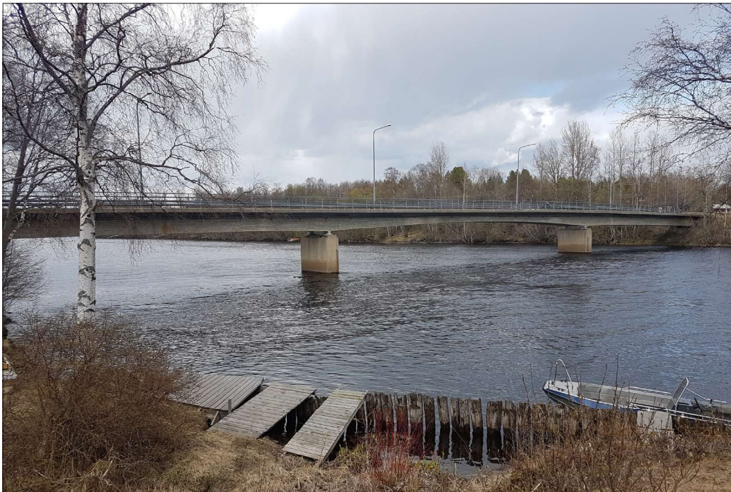
Befintlig bro mellan Östteg och Ön.
