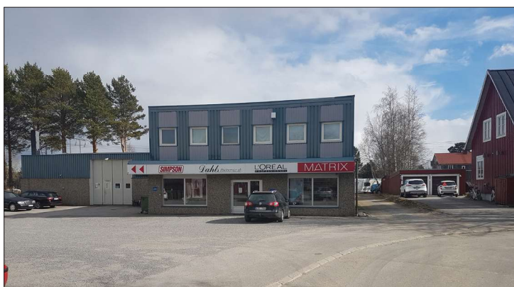
Verksamhetslokaler i slutet av Björkågatan. Bakom dessa anläggs ny väg mellan Ön och Norra Obbolavägen.
