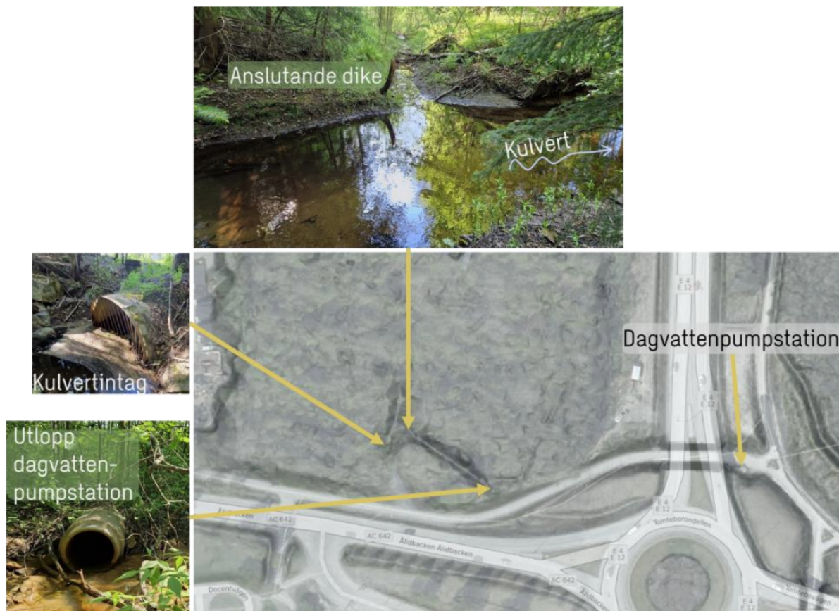
Figur 23. Översikt lokalisering av befintlig dagvattenpumpstation med utlopp och dike som ansluter till Kolbäcken (Sweco, 2023).
