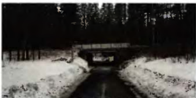
Passage under Ersmarksvägen
