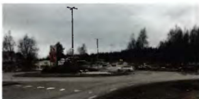
Rondell vid Formvägen/Cementvägen
