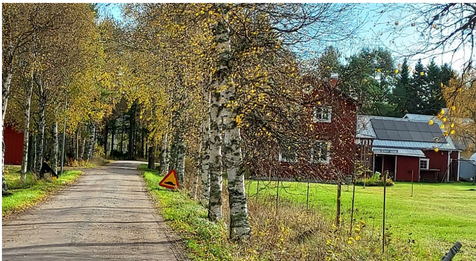
Foto på den aktuella byggnaden på fastigheten Ström 5:27 med solceller placerade på västra sidan mot innergården
