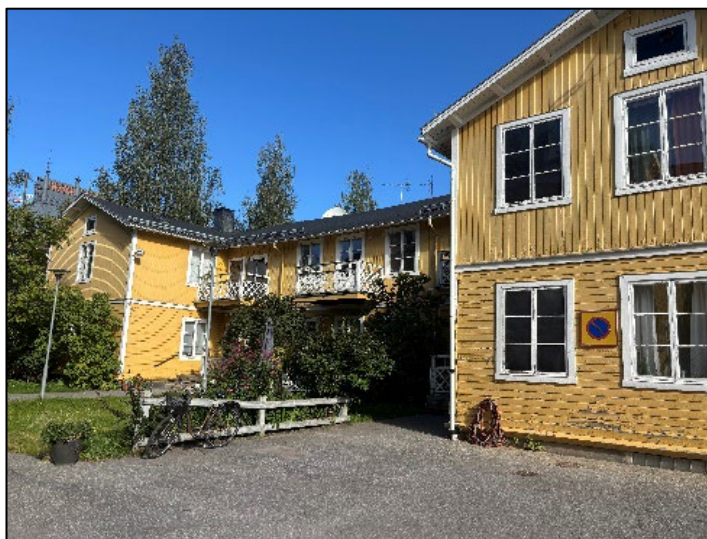
Ett utpekat särskilt värdefullt enstaka hus inne på fastigheten Vidar 1. Foto från platsbesök 2025-08-28.
