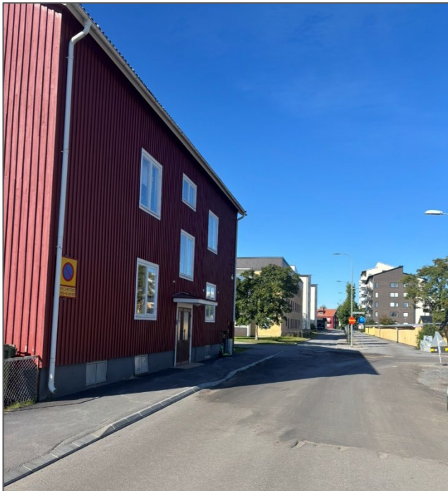
Befintligt bostadshus och del av omgivande bebyggelse. Foto från platsbesök 2025-08-28
