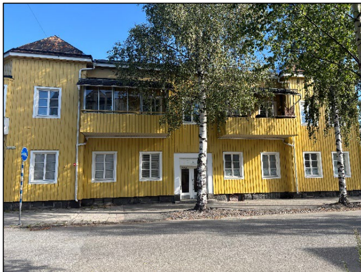
Bostadshus längs Kungsgatan. Foto från platsbesök 2025-08-28.
