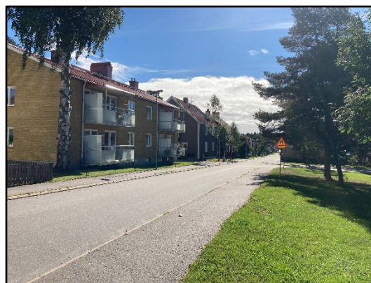
Figur 8. Södra Gimonäsvägen. Vy mot söder.
