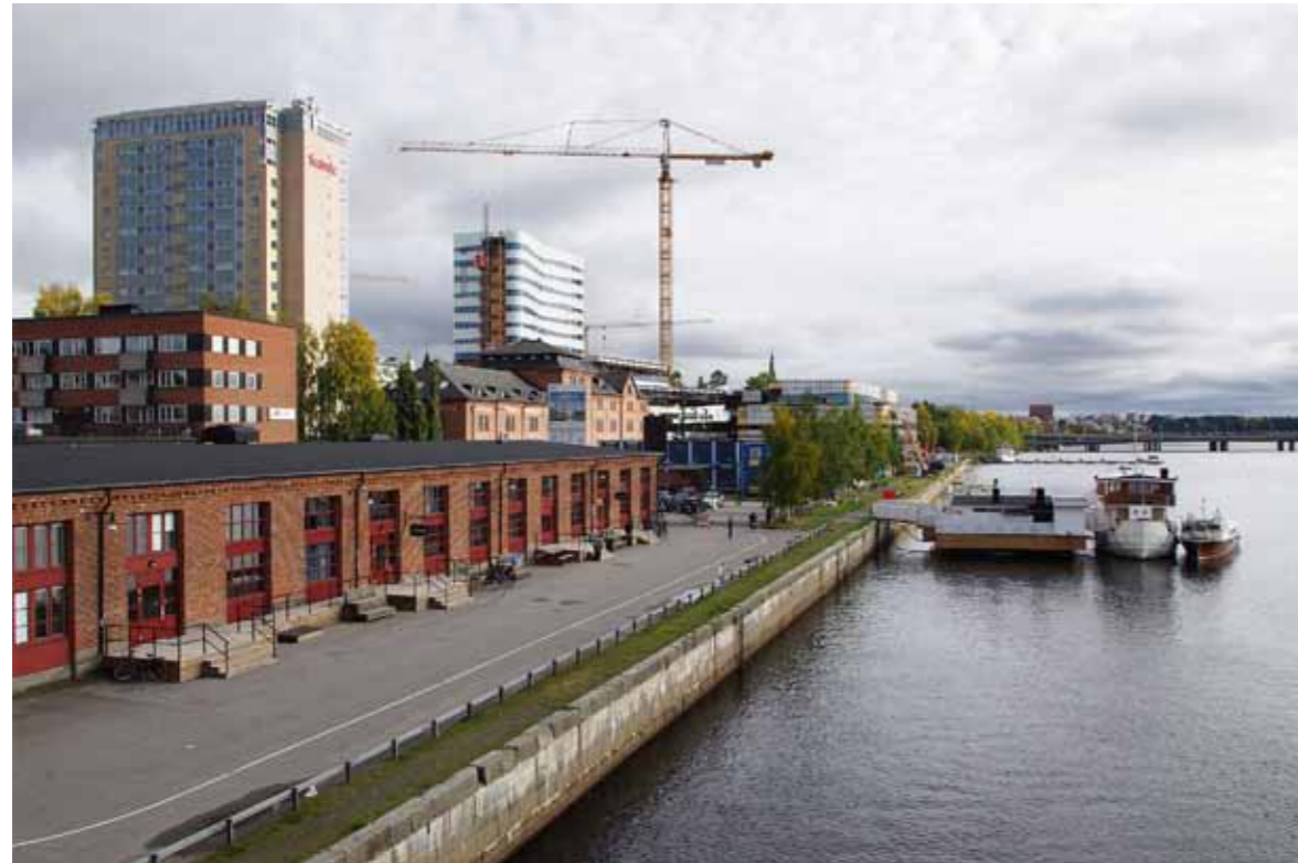
”Kulturväven” under uppförande på kajområdet i september 2013.
