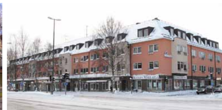
Skarpskytten 3, Västra Esplanaden 7-9.
