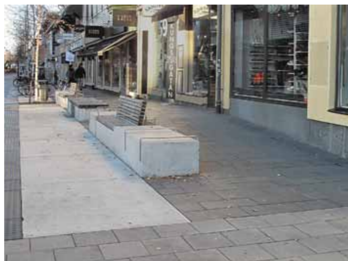
Kungsgatan, gågata med marknivåer anpassade till butikernas entréer.
