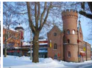
Gamla elverket, Wilhelm Stolpe 1892.
