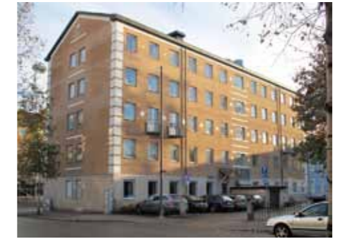
Intelligande kontorshus, påbyggt med två våningar.
