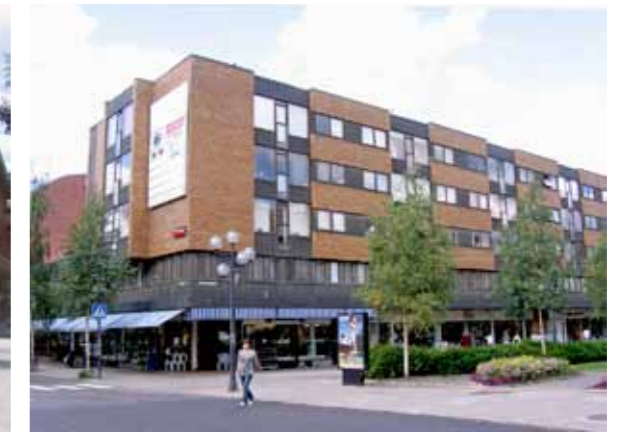
Frigg 7. Kontorshuset för försäkringsbolaget Valand. Erik Thelaus 1965.
