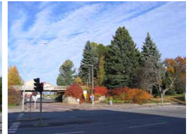
Järnvägsviadukten vid korsningen Järnvägsallén/Östra Kyrkogatan där en välkött plantering utgör ett positivt inslag i stadsbilden.
