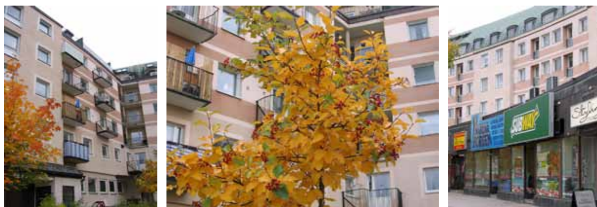
Kraften 11 med tilläggsisolerad men ändå välbevarad 50-talsfasad och en av centrala stadens finaste gårdsmiljöer.
