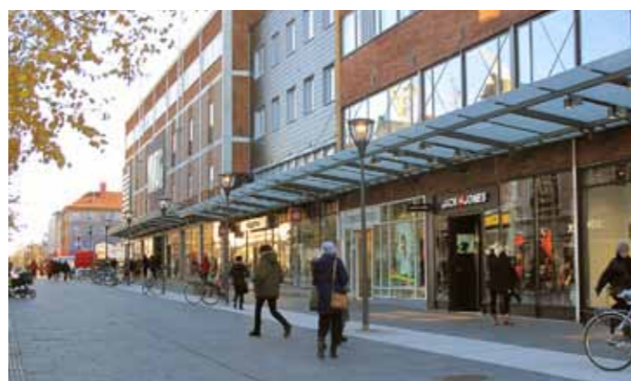
Kvarteret Odin utmed gågatan där arkader byggts bort och ersatts med skärmtak (ovan). Till vänster relativt elegant igenbyggda arkader mot Renmarkstorget.
