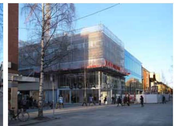
Vasagatan/Kungsgatan med kv Forsete under ombyggnad.
