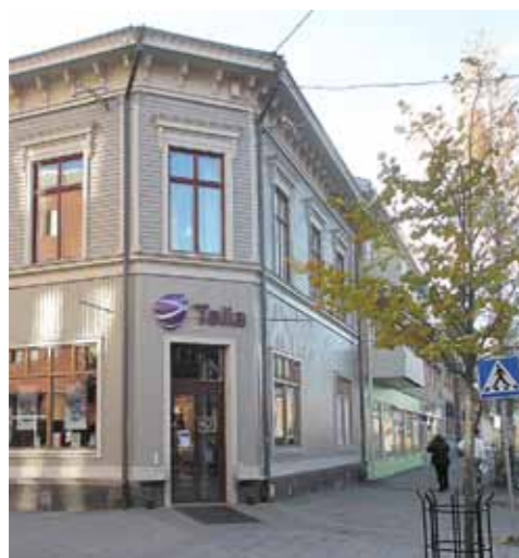
Butik med sänkt bjälklag för bekvämt insteg, kv Höder.
