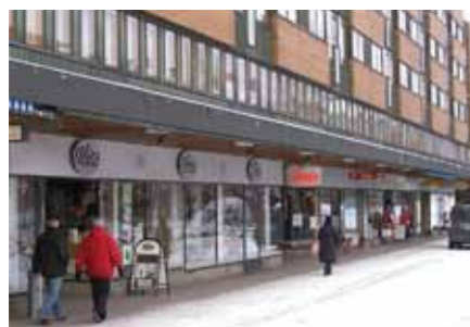
Indragen butiksfasad ger skydd och ökad gångyta.
