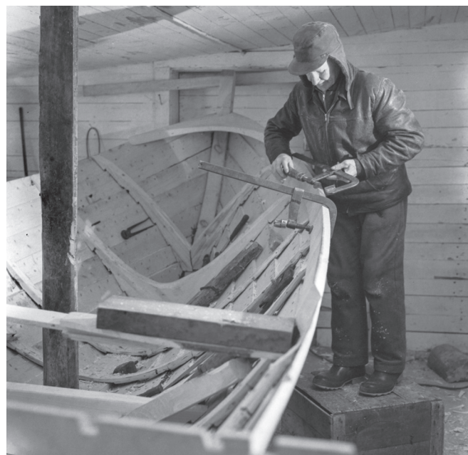
Holger fäster båtens inre sudband, relingslist. Ordet sud används om den klinkade båtsidan. Överst på denna sätts ett inre och yttre sudband.
