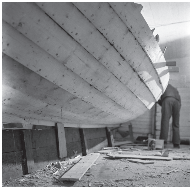
Båtsidan, suden, sätts samman med hjälp av hundratals båtspikar av platt typ.
