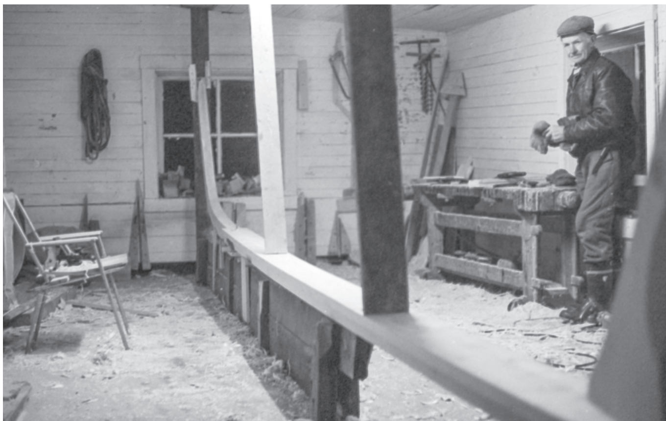
Första steget inne i verkstaden är att montera kölen, som är gjord av en senvuxen granstam.
