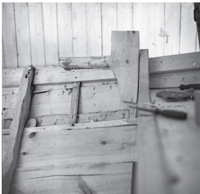
Årtullen är nu inplacerad, men håbandet av en vidja, läderrem eller repslinga för åran har ännu inte monterats.
