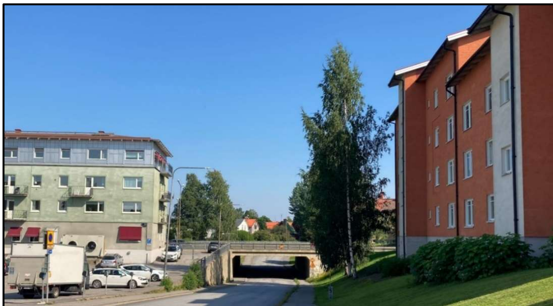
Figur 15. Nybrogatan, tunnel under Tegsesplanaden. Kv. Bilen 2 till vänster och kv. Bågen till höger i bild.
