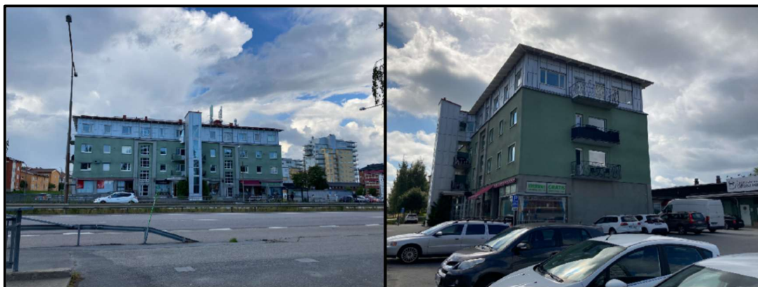
Figur 13. Byggnad mot Tegsesplanaden på fastigheten Bilen 2. Till vänster: vy från öst. Till höger: Vy från norr
