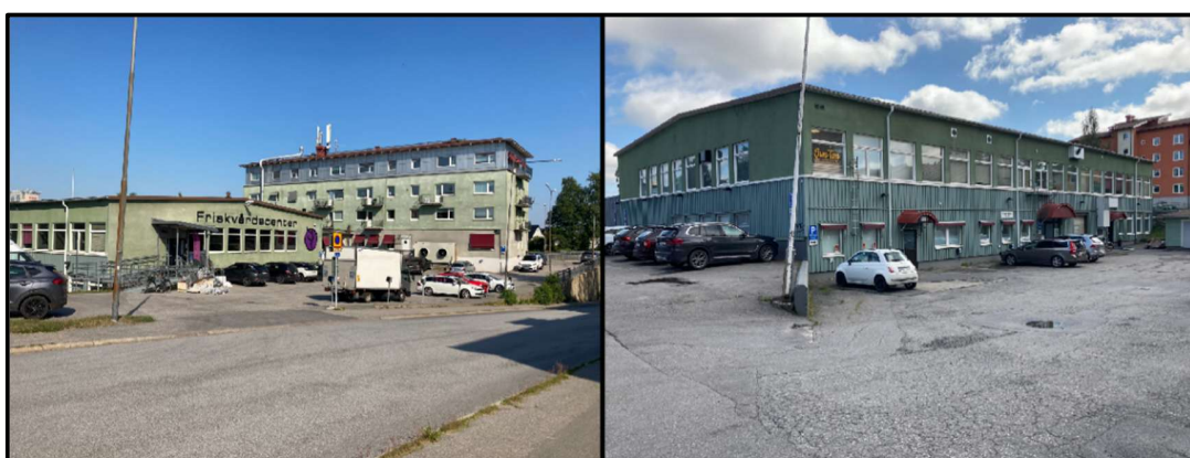
Figur 14. Verksamhetsbyggnad på fastigheten Bilen 2. Till vänster: Vy från sydväst. Till höger: Vy från nordväst.
