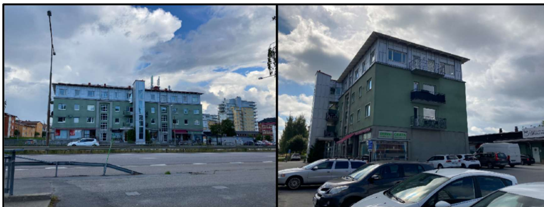
Figur 13. Byggnad mot Tegsesplanaden på fastigheten Bilen 2. Till vänster: vy från öst. Till höger: Vy från norr
