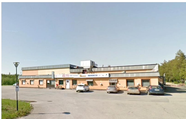
Figur 4 Befintlig byggnad på fastigheten Kardan 1 (foto Google Maps).
