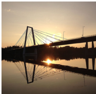
Kolbäckbron – en vacker pylonbro och ett signum för Umeå. Bron invigdes år 2001 och är Umeå tätorts fjärde vägbro över Umeälven. Den tar avstamp på Ön och ingår som del i ringleden. Över bron passerar E4.
