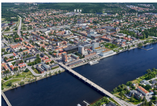
Över Tegsbron går väg 503, tidigare europaväg, och som är en viktig länk till Teg.
