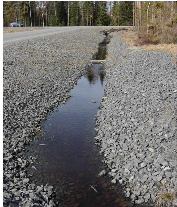
Figur 18. Punkt 5. Nyanlagt vägdike med lugnt rinnande vatten ansluts mot dike i punkt 4.
