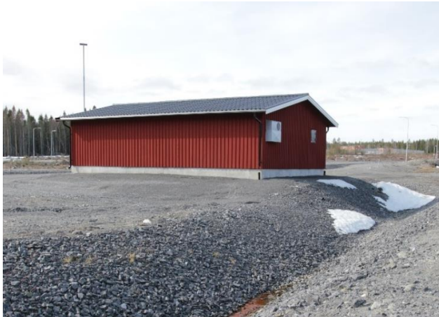
Figur 23. Punkt 10a. Pumpstation byggd i tidigare etapp.
