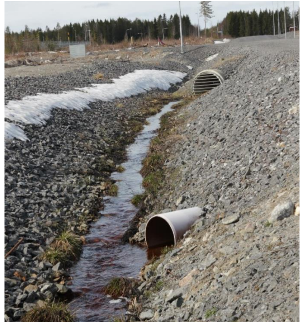
Figur 24. Punkt 10b. Dagvattenutlopp (övre, med galler) och utlopp för pumpstationens nödrädd (nedre). Rinnande dagvatten.
