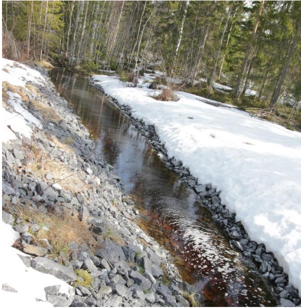
Figur 19. Punkt 6. Nytt dike innan övergång till befintligt dike som är ett gammalt vägdike. Strömmande vatten.
