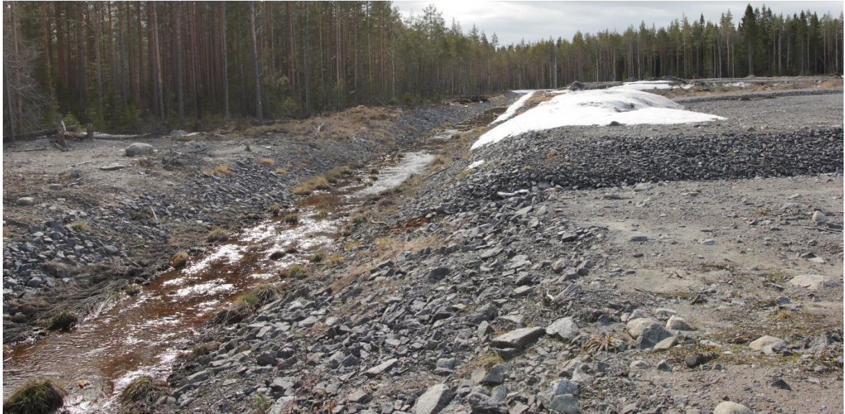
Figur 25. Punkt 10c. Dike nedströms pumpstation. Låg vattennivå.
