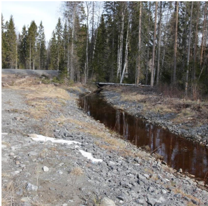
Figur 26. Punkt 10d. Samma dike som i föregående bild men i riktning mot utredningsområdet. Högre vattennivå, svagt strömmande.
