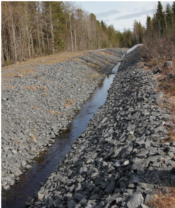
Figur 17. Punkt 4. Nytt dike in mot etapp 3. Rinnande vatten.
