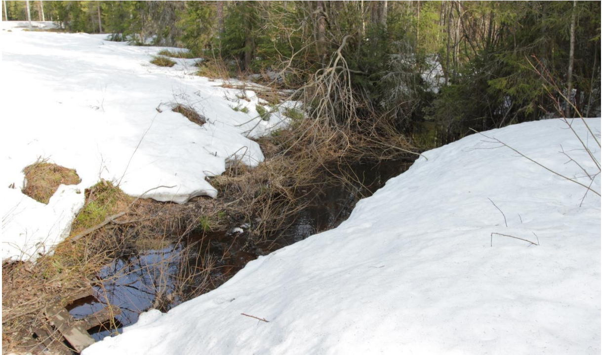
Figur 22. Punkt 9. Västra diket som leder dagvattnet från befintligt bostadsområdet genom utredningsområdet. Lugnt rinnande.
