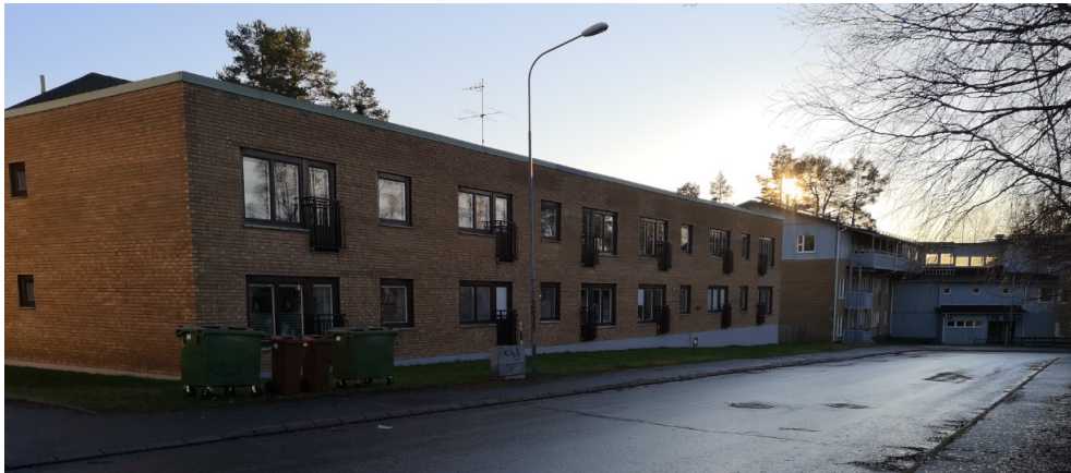
Figur 2. Vindfället 9 närmast i bild och Vindfället 10 med påbyggnad i bakgrunden.
