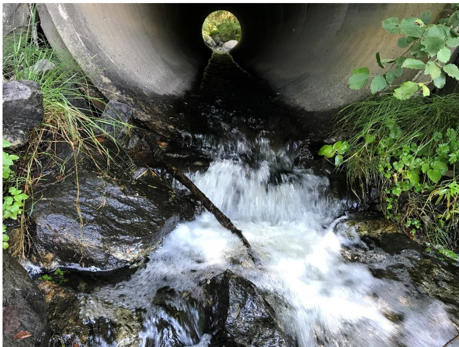
Figur 28. Vägtrumma som ligger fel och troligen utgör ett hinder för fiskvandring.
