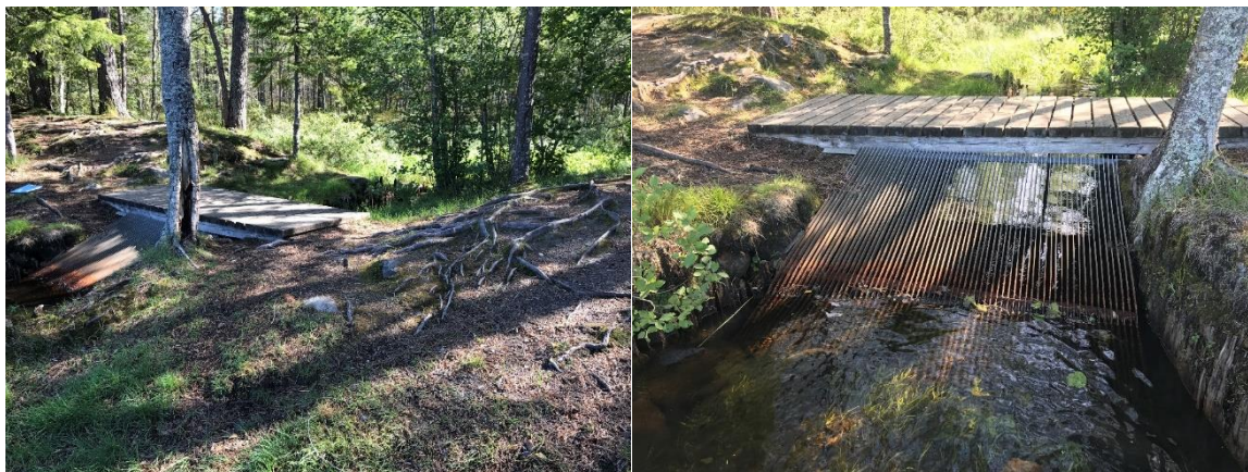
Figur 33. Den gamla dammvallen vid delsträckans slut med ett galler vid utskovet.
