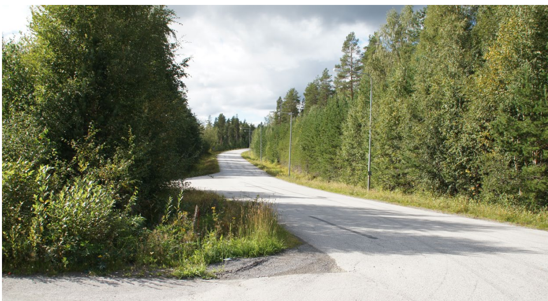
Foto 2, längs Kungsvägen taget mot väster. Fotot är taget strax öster om korsningen med vägen mot Tomterna. Från denna punkt stiger vägen mot väster. Planområdet omfattar delar av skogsområdet till höger i bild. (Foto: WSP)
