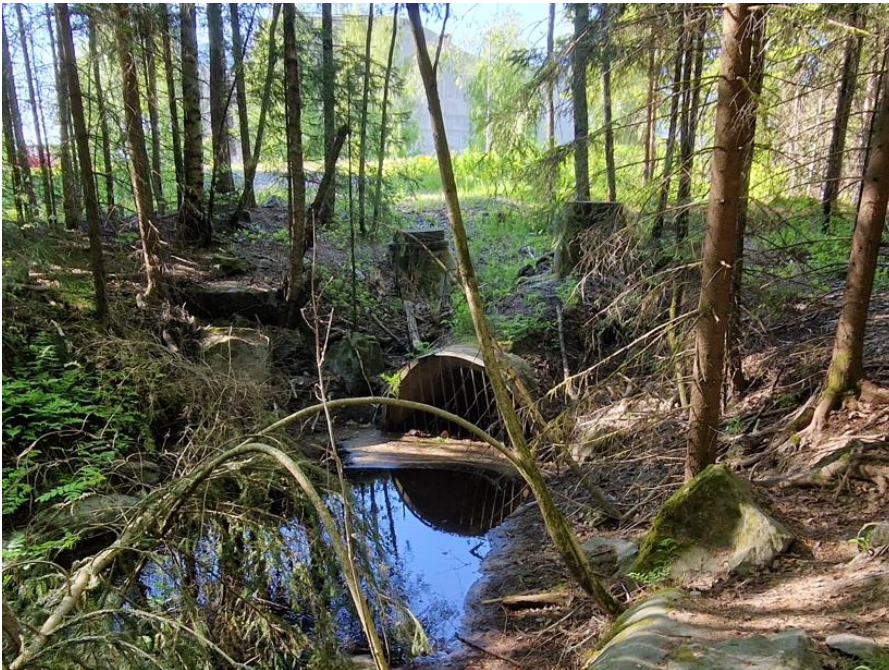
Figur 9. Befintligt galler, med en vall av grenar och skräp vid kulvertens inlopp. Bild: Sweco.
