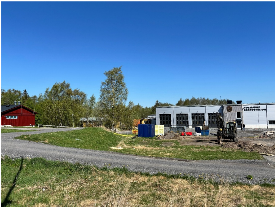
Fastigheterna sett från Storgatan. Väster om brandstationen finns en befintlig byggnad som används av hemvärnet. Foto från platsbesök 2026-05-21.
