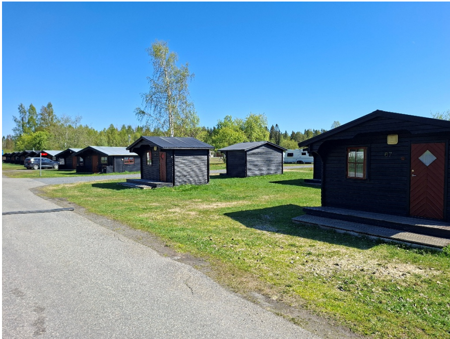
Befintliga mindre övernattningsstugor. Foto från platsbesök, 21 maj 2026.
