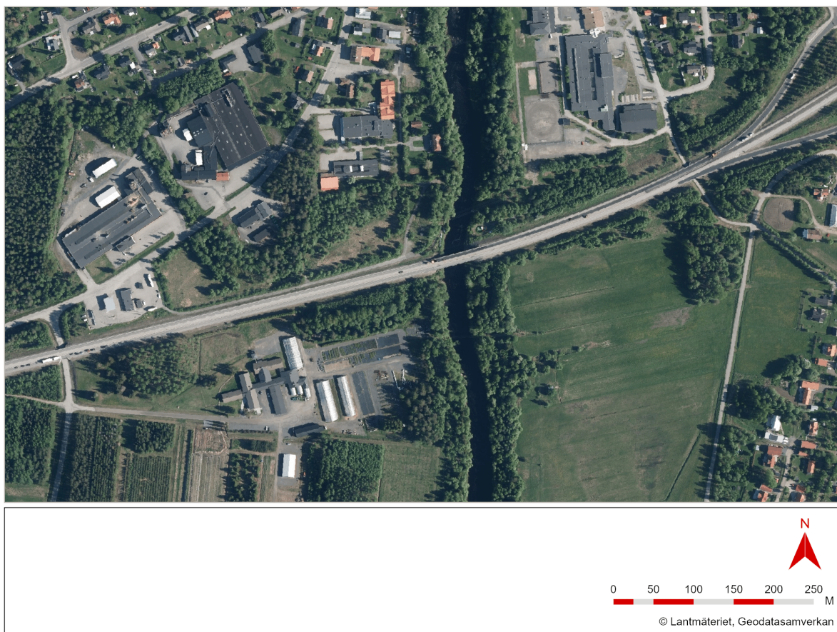
Figur 2. Befintlig vägbro för passage av E4 över Sävarån.
