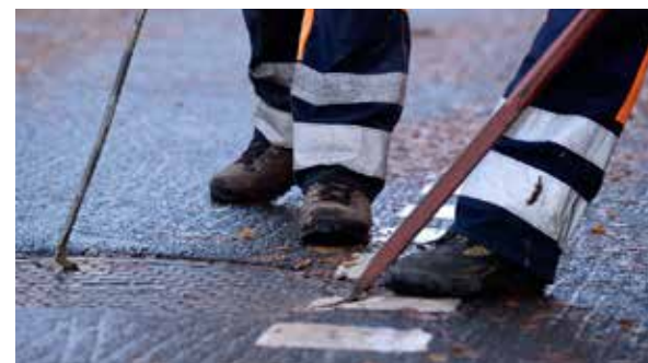
Öppning av dagvattenbrunn.
