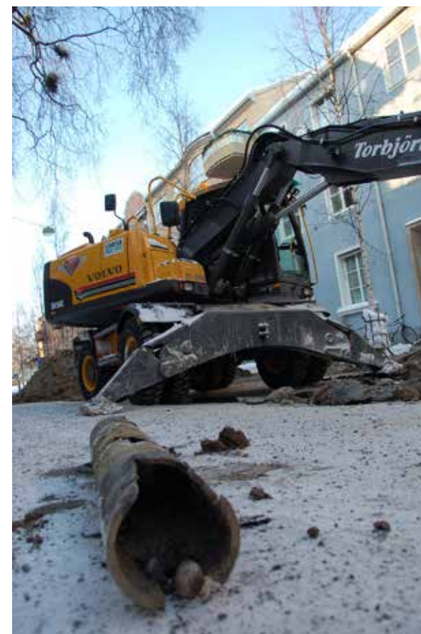
Vattenläcka Nygatan, Umeå.
