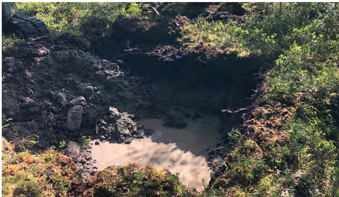
Bild 2: Provgrop med intrasande schaktvägg och snabbt inrinnande grundvatten.
