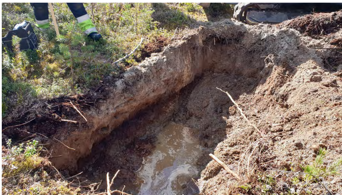
Bild 1: Provgrop med inrasande schaktvägg
