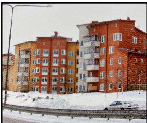
Figur 24. Kv Bågen söder om planområdet.
