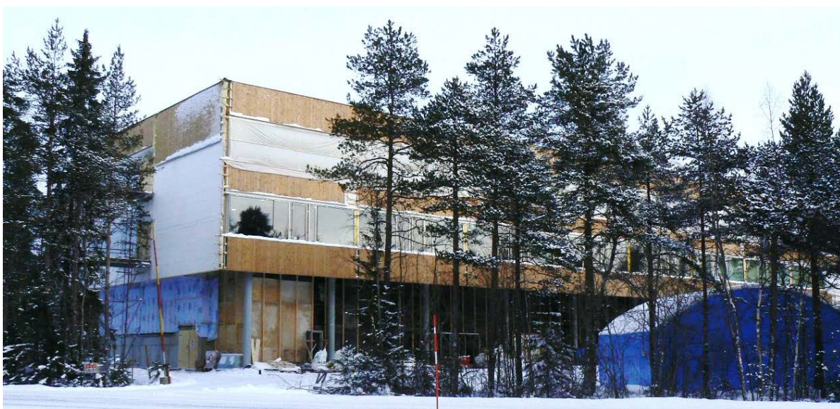
Figur 3-9. Minerva gymnasieskola under uppförande. Skola för ca 800 elever.
