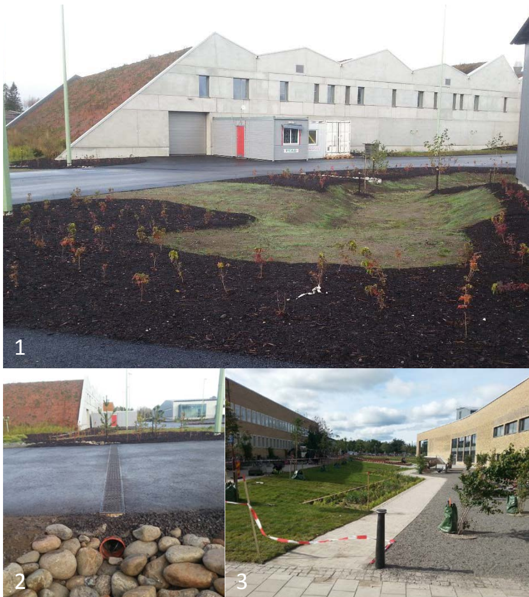
Figur 5-4. 1) Anläggning för lokalt omhändertagande av dagvatten vid reningsverket på Ön i Umeå. 2) Dagvattenränna där dagvattenstråket kan korsa vägbanan. Dagvattenrännan fungerar även som avvattning för vägen. 3) Anläggning för lokalt omhändertagande av dagvatten på campusområdet. Källa: Sweco.
