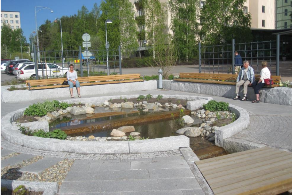
Figur 23. Överdämningsyta/fontän som fungerar som fördröjning av dagvatten (foto WSP).
