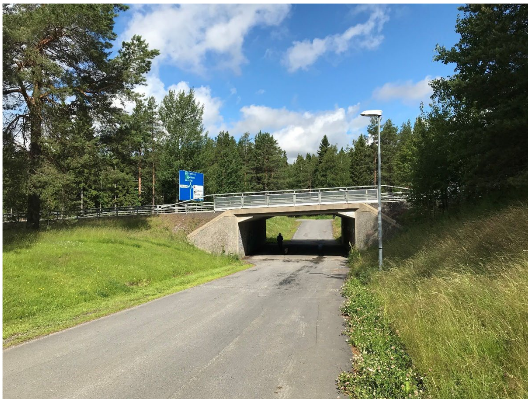
Figur 15. Gång- och cykelväg väster om planområdet som leds i en tunnel under väg E4.
